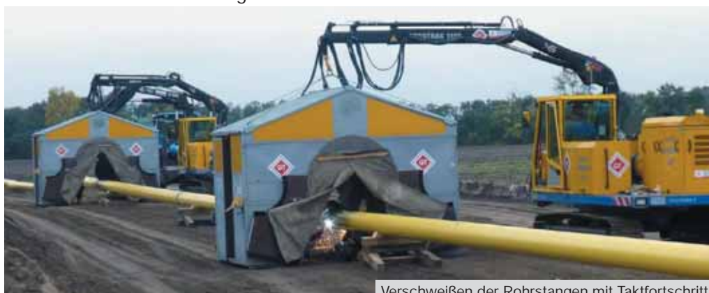
Verschweißen der Rohrstangen mit Taktfortschritt
