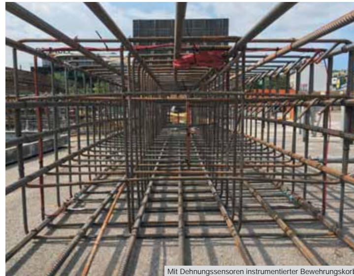
Mit Dehnungssensoren instrumentierter Bewehrungskorb
