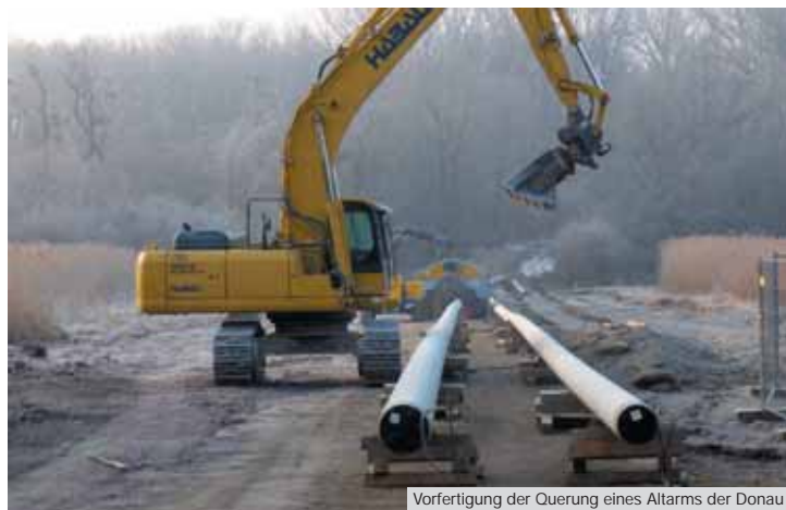
Vorfertigung der Querung eines Altarms der Donau
