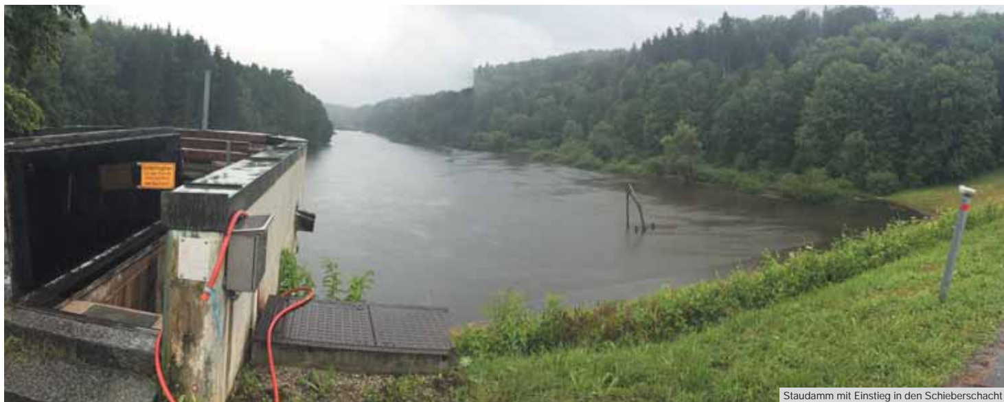
Staudamm mit Einstieg in den Schieberschacht
