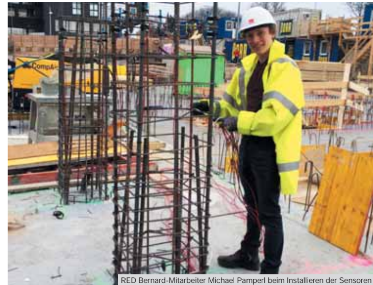
RED Bernard-Mitarbeiter Michael Pamperl beim Installieren der Sensoren
