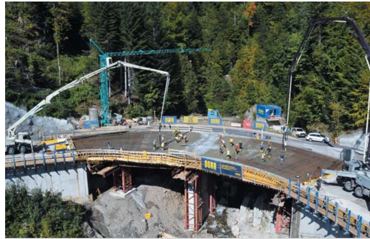
Hölltobelbrücke in der Bauphase
